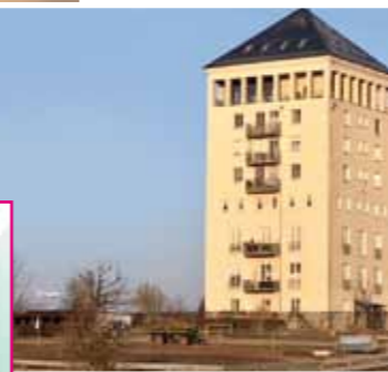
Der Wasserturm von Klotzsche
