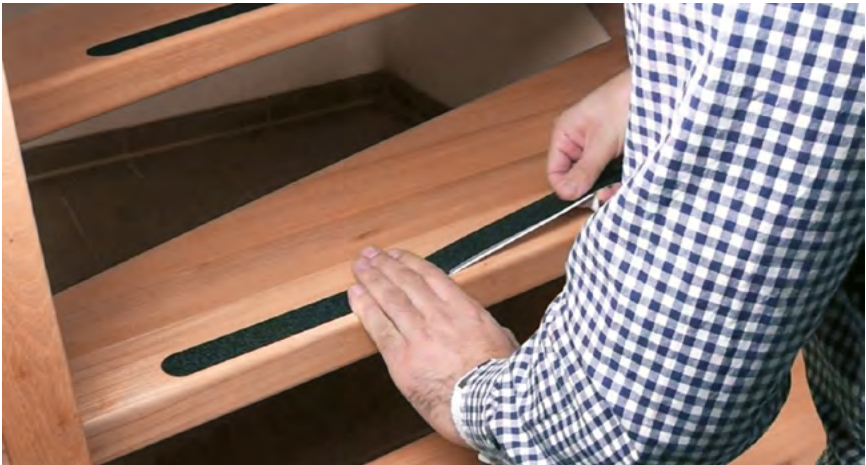
Treppe mit Antirutschstreifen
