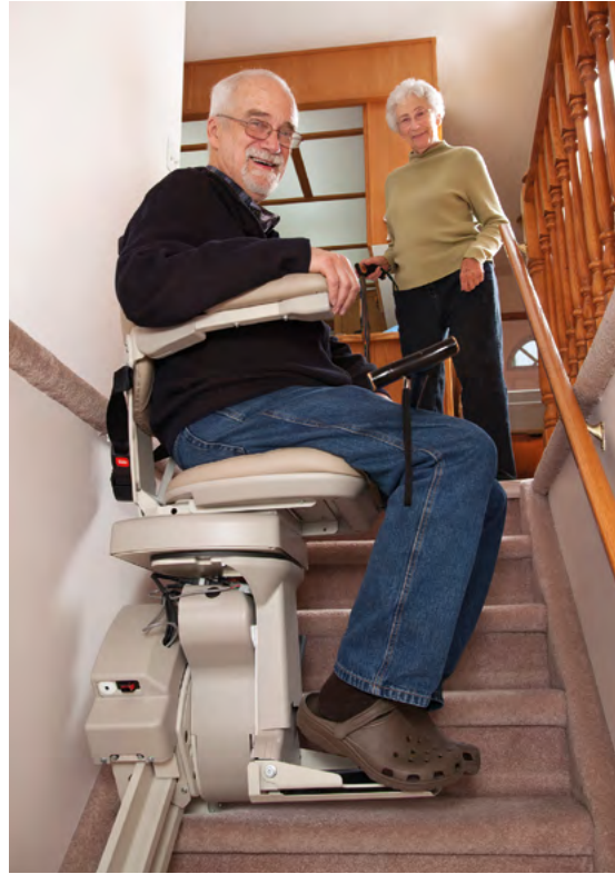
Nachträglich eingebauter Treppenlift
