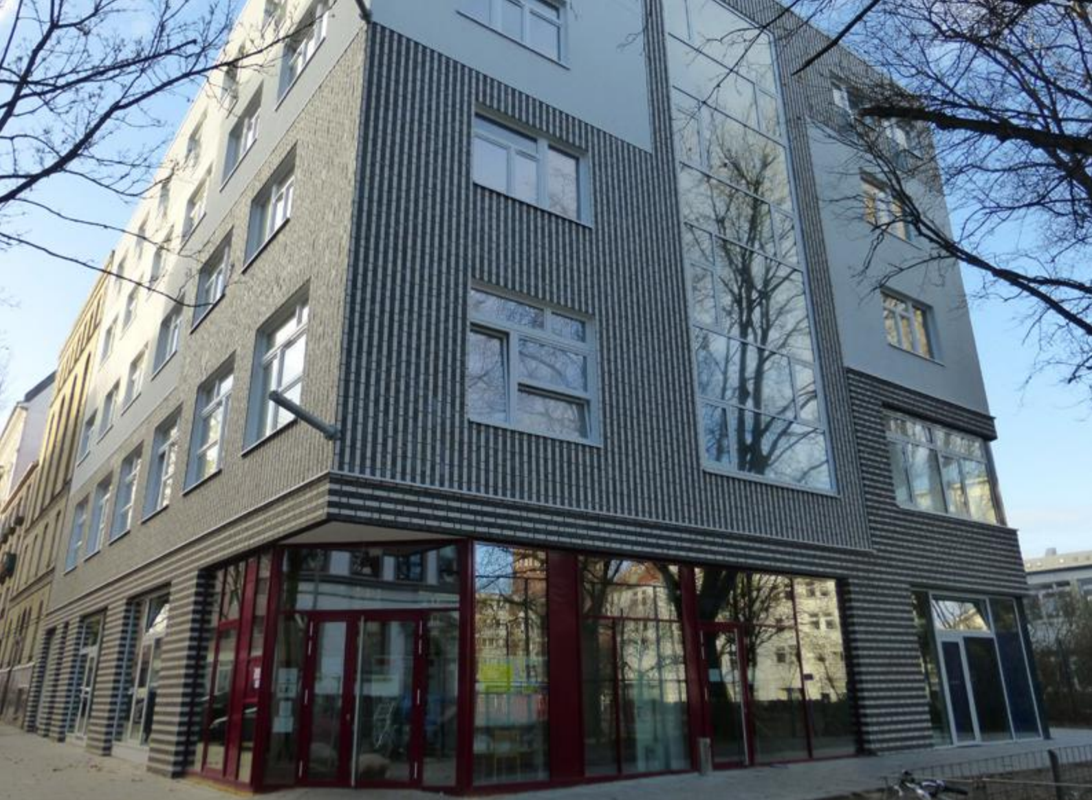
Der Neubau des Integrations- und Familienzentrums in St.Georg
