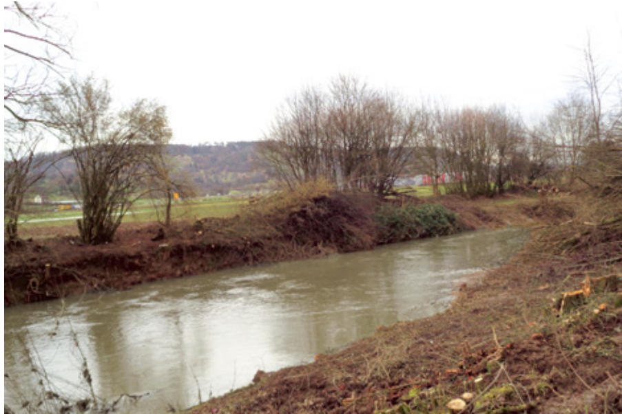
Auf einer Länge von über einem Kilometer zwischen Winterbach und Remshalden renaturiert WOLFF & MÜLLER die Rems. (Foto: WOLFF & MÜLLER)
