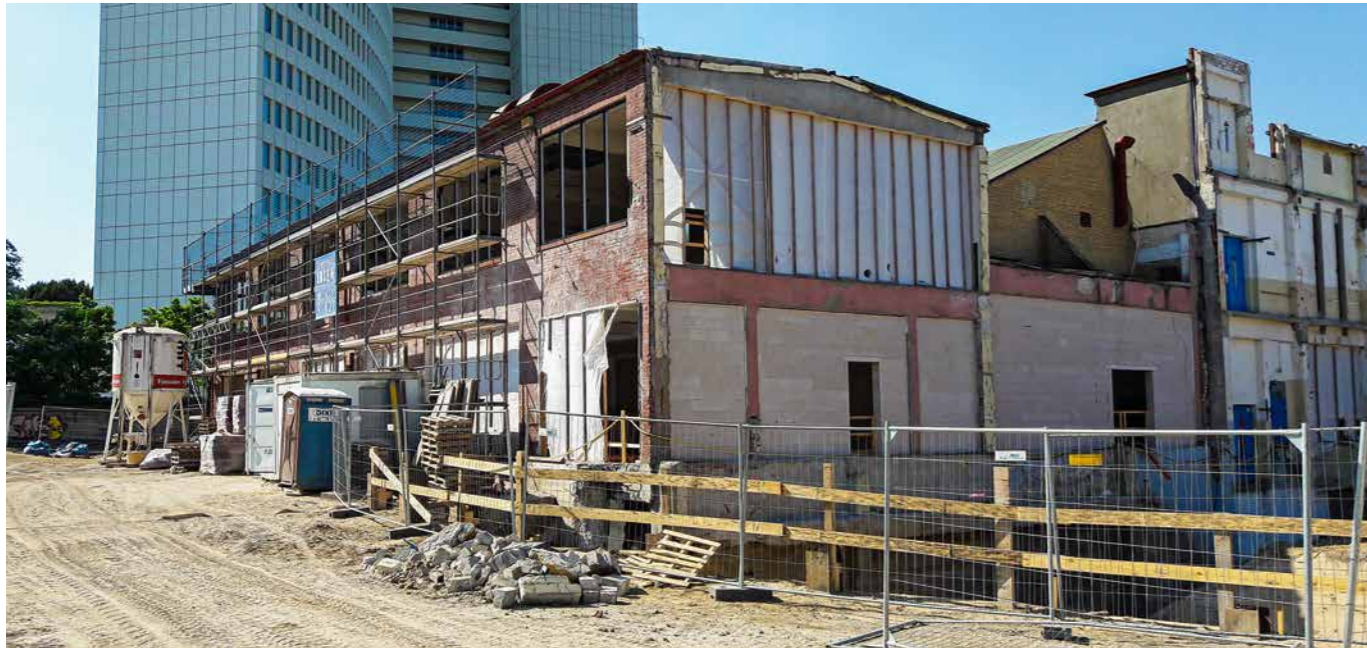
Hier entsteht am alten Ort der neue Handwerkerhof: Außenansicht des Kolbenhof-Geländes.
