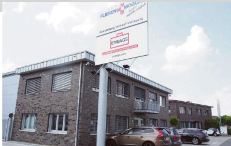
In Hittfeld hat das Unternehmen Mogck unlängst diesen Neubau übernommen, der die Handschrift von Hansen Hallen trägt und optisch überzeugt.
