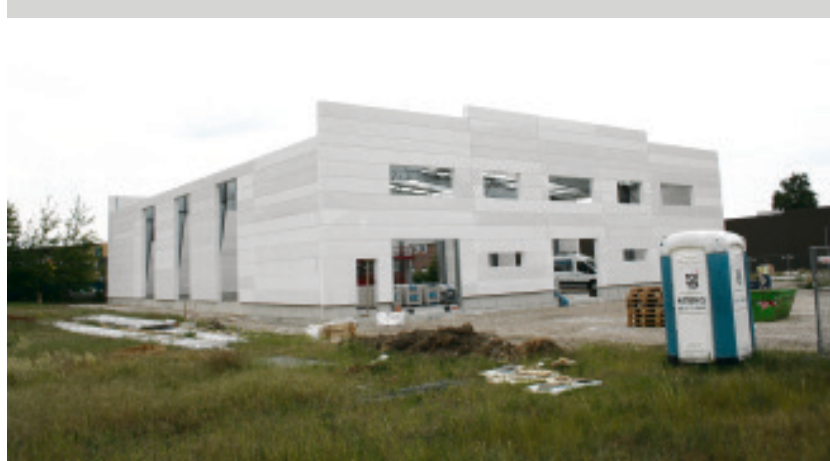
Noch im Bau: Die Stahlkonstruktion mit Porenbetonwänden entsteht zurzeit in Hannover.
