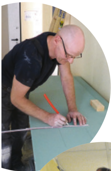
Mit Leichtbauteilen erhalten einige Räume im Haupthaus einen neuen Zuschnitt.
