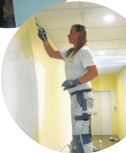
Letzte Malerarbeiten in den Fluren: Die senkrechten Lichtbänder sind bereits angeschlossen.
