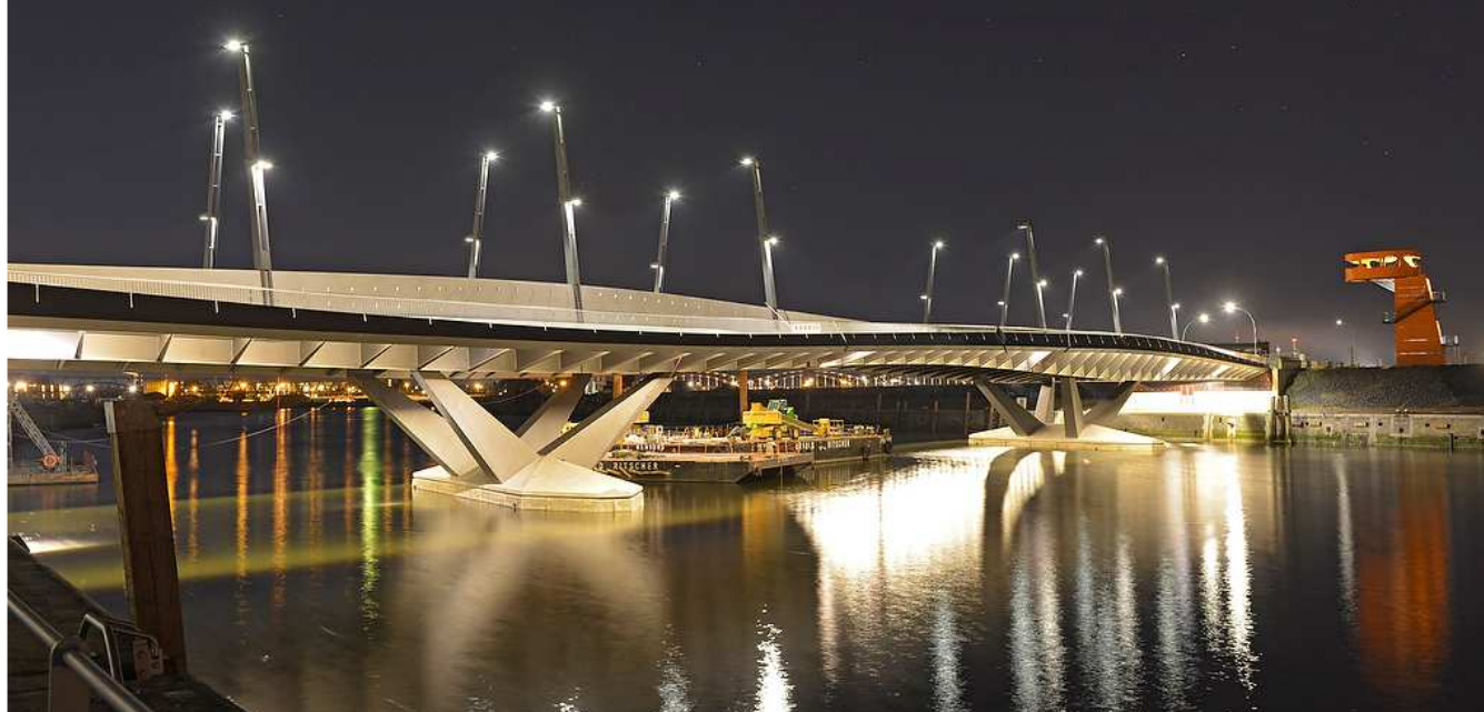
Baakenhafenbrücke Fertiggestellt: August 2013
