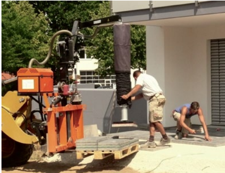
Der Optimas Vacu-Lift kann bis zu 140 kg heben und bewegen. Betonplatten, Bordsteine, Fließrinnen u.v.m. lassen sich so schnell und ohne Kraftaufwand verlegen. (Foto: Optimas GmbH)
