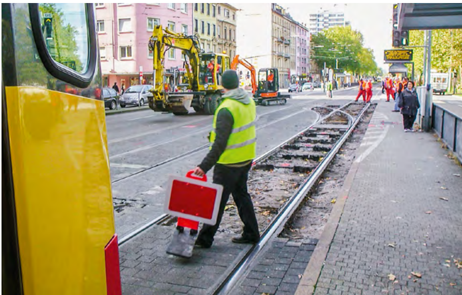
Der Posten überzeugt sich, dass die Beschäftigten die Arbeitsstelle räumen. Dann darf er durch das Entfernen des Sh-2-Signals dem Fahrzeugführer signalisieren, dass die Baustelle passiert werden darf.
