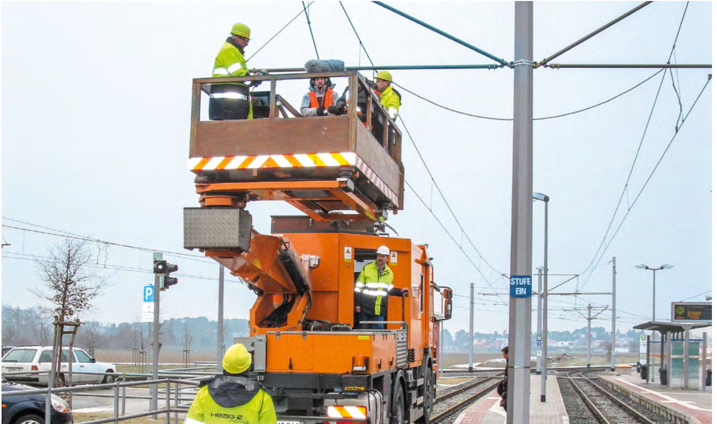
Für Arbeiten auf dem Potenzial der Fahrleitung muss jede Hubarbeitsbühne doppelt isoliert sein.
