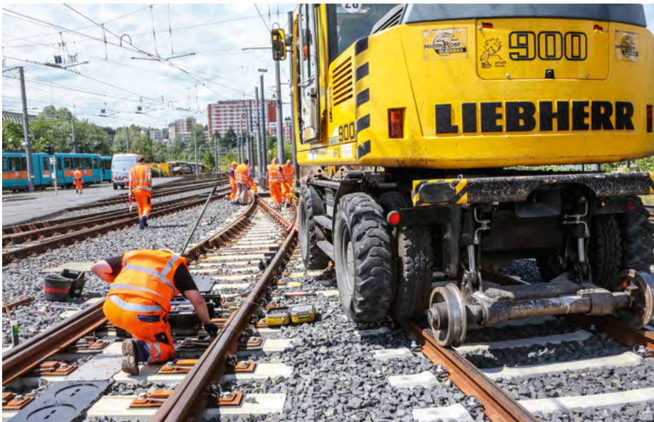
Bei der Gefährdungsbeurteilung und der Auswahl von Sicherungsmaßnahmen sind auch die Gefährdungen durch bewegte Arbeitsmaschinen zu berücksichtigen.
