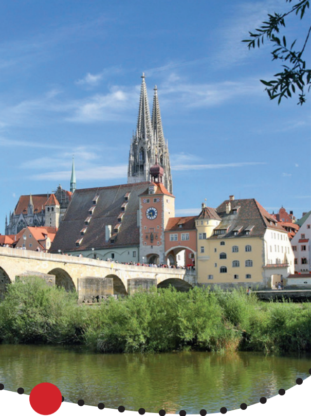
Zurzeit noch Baustelle – im Sommer sollen die Steinerne Brücke und Regensburg in neuem Glanz erstrahlen. Foto: Regensburg Tourismus GmbH
