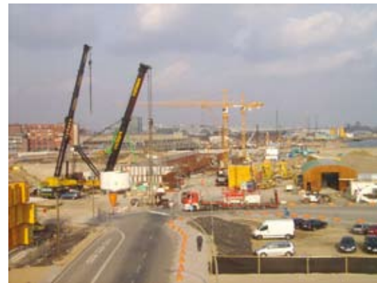
Abb.: U-Bahn-Baustelle in der Hafencity
