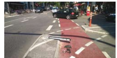
Abb.: umgefahrener Stahlpfosten
