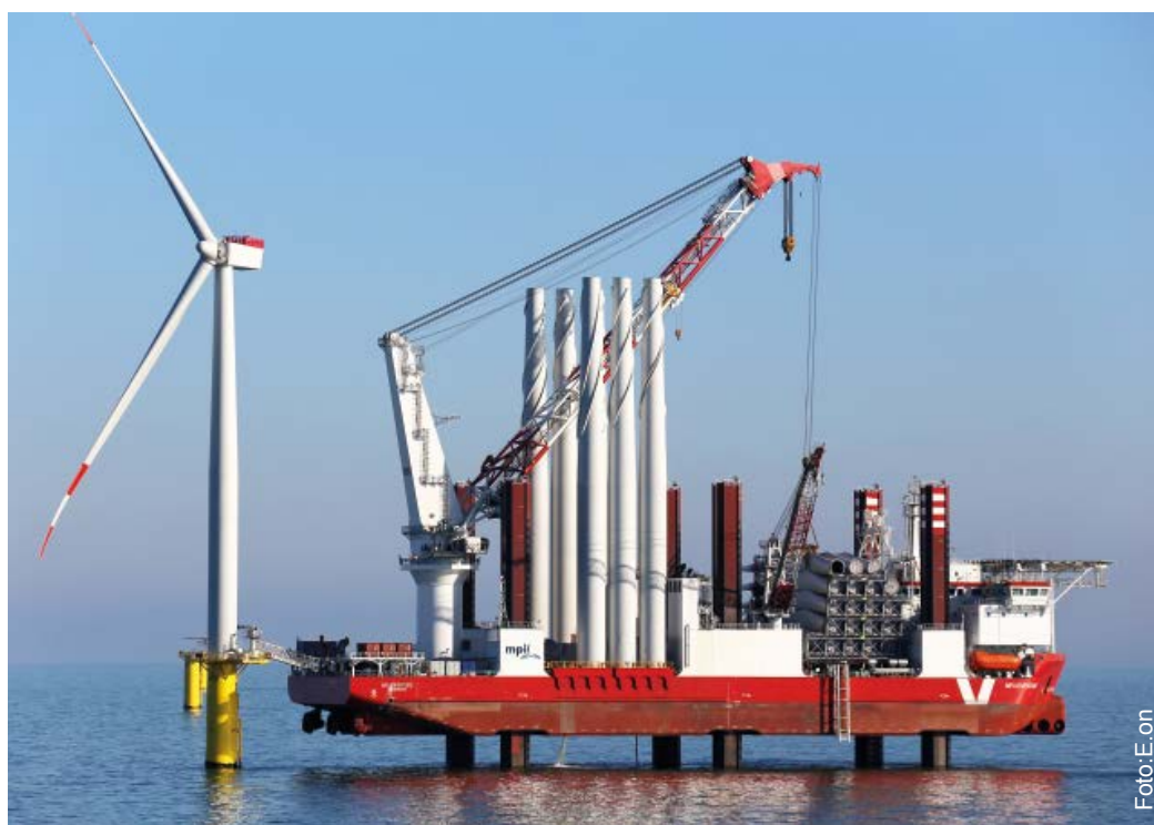
Ein Windrad wird in der Nordsee von einer Jackup-Plattform aus installiert
