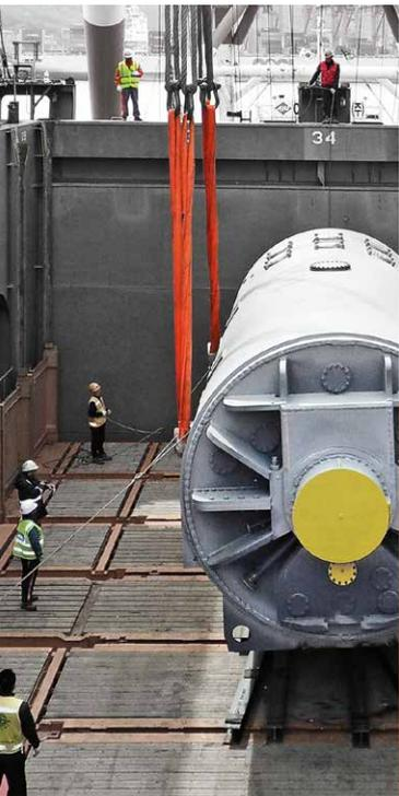
Besonders schwer war mit einem Gewicht von 343 Tonnen eine Gasturbine: Hapag-Lloyd verschiffte sie von Charleston, USA, nach Busan in Südkorea. Mit Schwimmkränen wurde das Schwergewicht im Ladehafen an Bord gehoben – und im Zielhafen wieder gelöscht.
