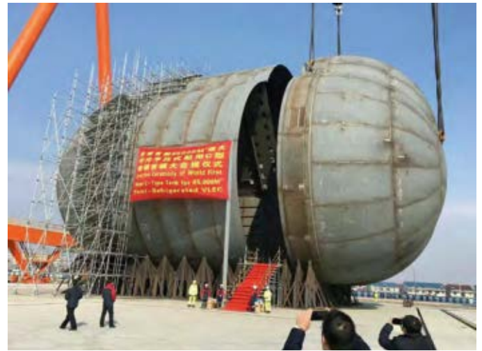
Gigant. Die „Star-Trilobe“-Tanks haben die Form dreier ineinandergeschobener Zylinder. Das Volumen jedes der 27 Meter hohen und 40 Meter langen 85k-Tanks beträgt mehr als 23.000 m 3 .
