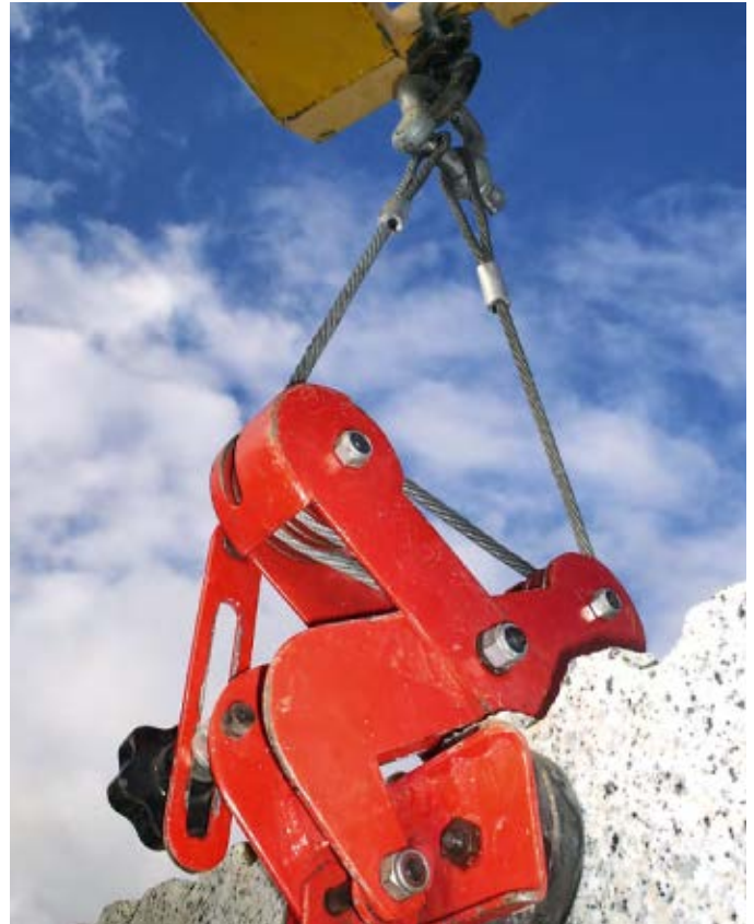
Sicherung. Granitplatten erfordern besonders stabile Hubvorrichtungen.
