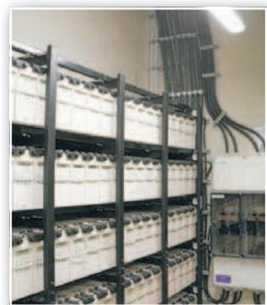
**Batterieraum** Wichtig für die unterbrechungsfreie Stromversorgung
