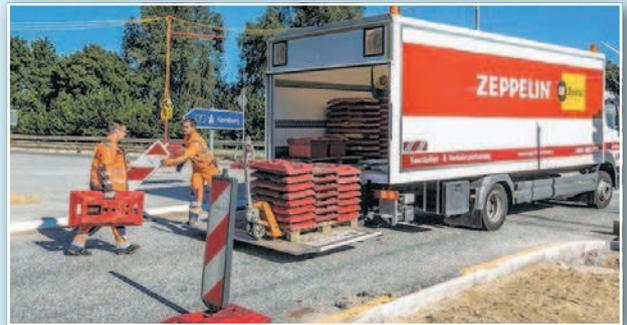
Mitarbeiter richten eine Baustelle ein: Die rot-weißen Baken werden auf Füße aus Recycling-Kunststoff montiert Foto: pr
