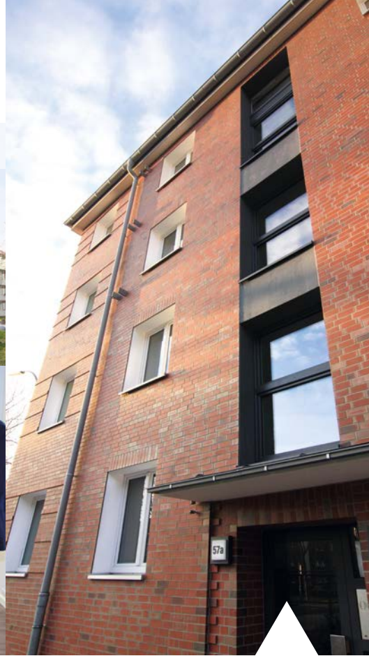
Wieder ein Modernisierungsabschnitt abgeschlossen: Bürgerweide 57 a-e
