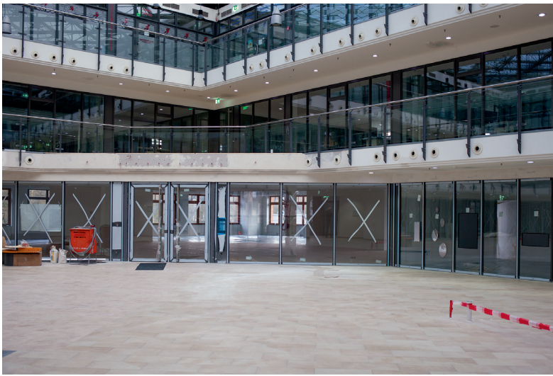
Noch wird im Obergeschoss der Eulenkug-Passage gebaut, doch es geht zügig voran.
