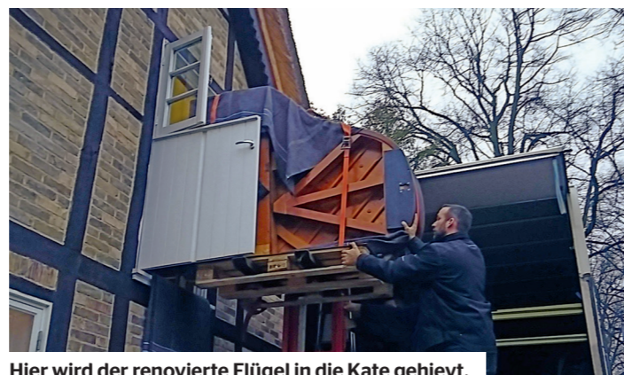
Hier wird der renovierte Flügel in die Kate gehievt.
