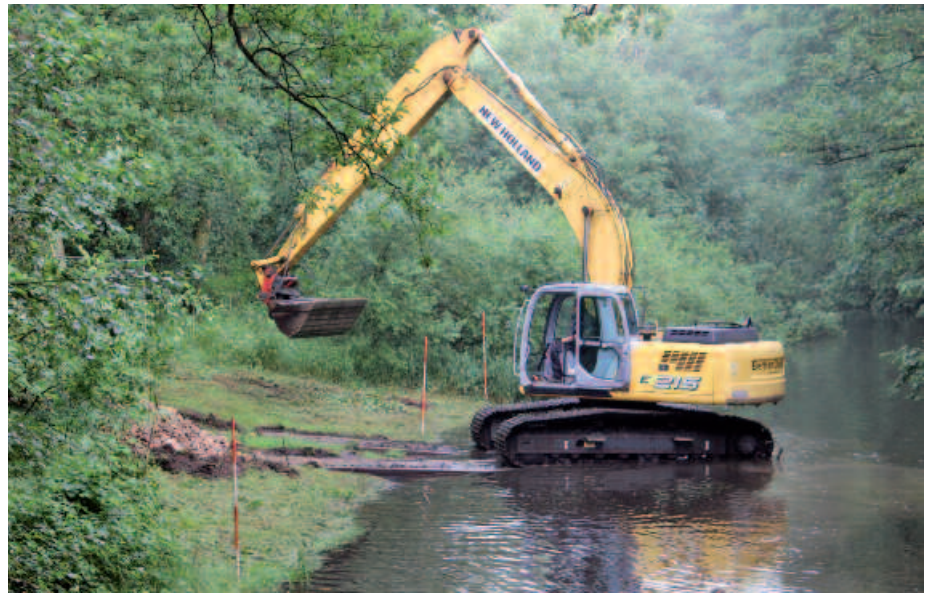
Nördlich des Hohenbuchenparks in Poppenbüttel baut ein Baggerfahrer eine Rausche aus Kies und Geröll – hoffentlich ein zukünftiger Laichplatz für Forellen [Projekt Lebendige Alster]
