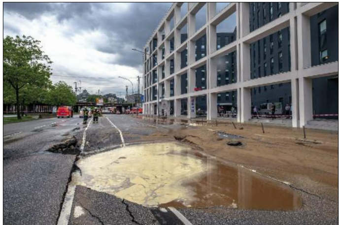
24.07.2017, TH2, Hammerbrook: Austritt mehrerer tausend Kubikmeter Wasser nach Wasserrohrbruch. Ca. 2.000 Kubikmeter aus einer Tiefgarage gelenzt, Verkehrschaos im Feierabendverkehr durch mehrstündige Vollsperrung der Spaldingstraße sowie Einschränkungen in der Wasserversorgung der Hamburger Innenstadt
