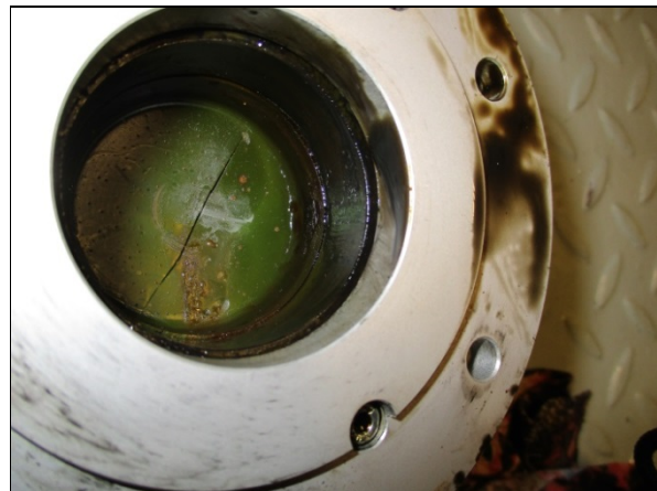
Abbildung 7: Riss im Hallgenerator
