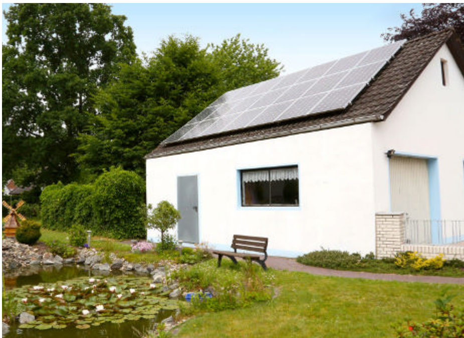
Die Solarstromunterstützung: Der Ertrag einer Photovoltaik-Anlage hängt von Größe und Ausrichtung ab. Familie Skusa montierte die Photovoltaik-Anlage auf dem Dach der Garage. Sie umfasst eine Fläche von 26 Quadratmetern und ist nach Südwesten ausgerichtet.
