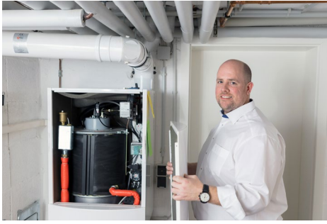
Der Wärmespeicher (180 l für Brauchwasser, 570 l für Heizung) wird aus drei Wärmequellen bedient: Von einem Öl-Brennwertgerät, einer solarthermischen Anlage sowie einem wassergeführten Kamineinsatz.
