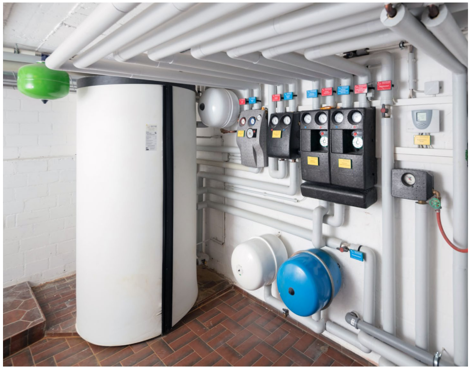
Der Wärmespeicher (180 l für Brauchwasser, 570 l für Heizung) wird aus drei Wärmequellen bedient: Von einem Öl-Brennwertgerät, einer solarthermischen Anlage sowie einem wassergeführten Kamineinsatz.
