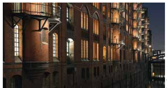
Die Speicherfassaden am Wandrahmsfleet mit neuer Beleuchtung
