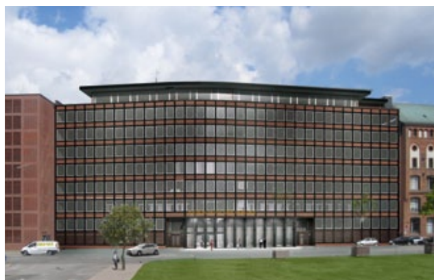
Das AMERON Hotel: Der elegante Schwung der Fassade ergibt sich aus dem Verlauf des Brookfleets auf der Gebäuderückseite.
