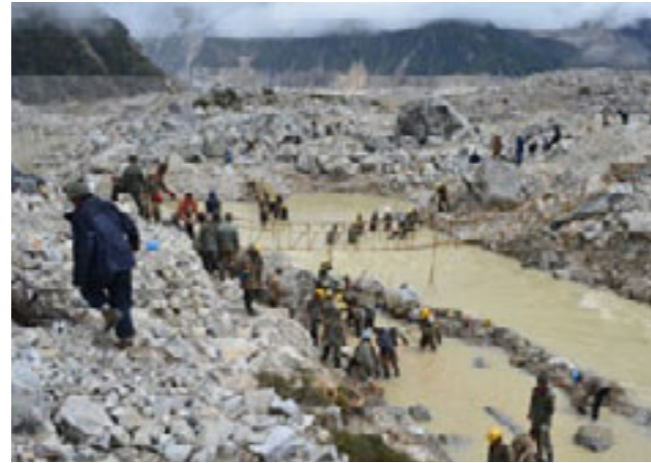
In Bhutan konnte der Ausbruch eines Gletschensees verhindert werden: In fünf Jahren Arbeit hatten 1.000 Arbeiter den Spiegel des kritischen Sees um fünf Meter gesenkt.
