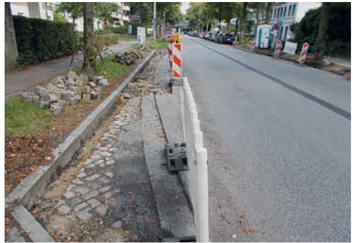
Stadteinwärts ist der neue Kantstein bereits gesetzt
