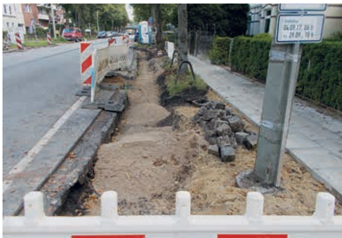
Stadtauswärts ist der alte Kantstein entfernt
