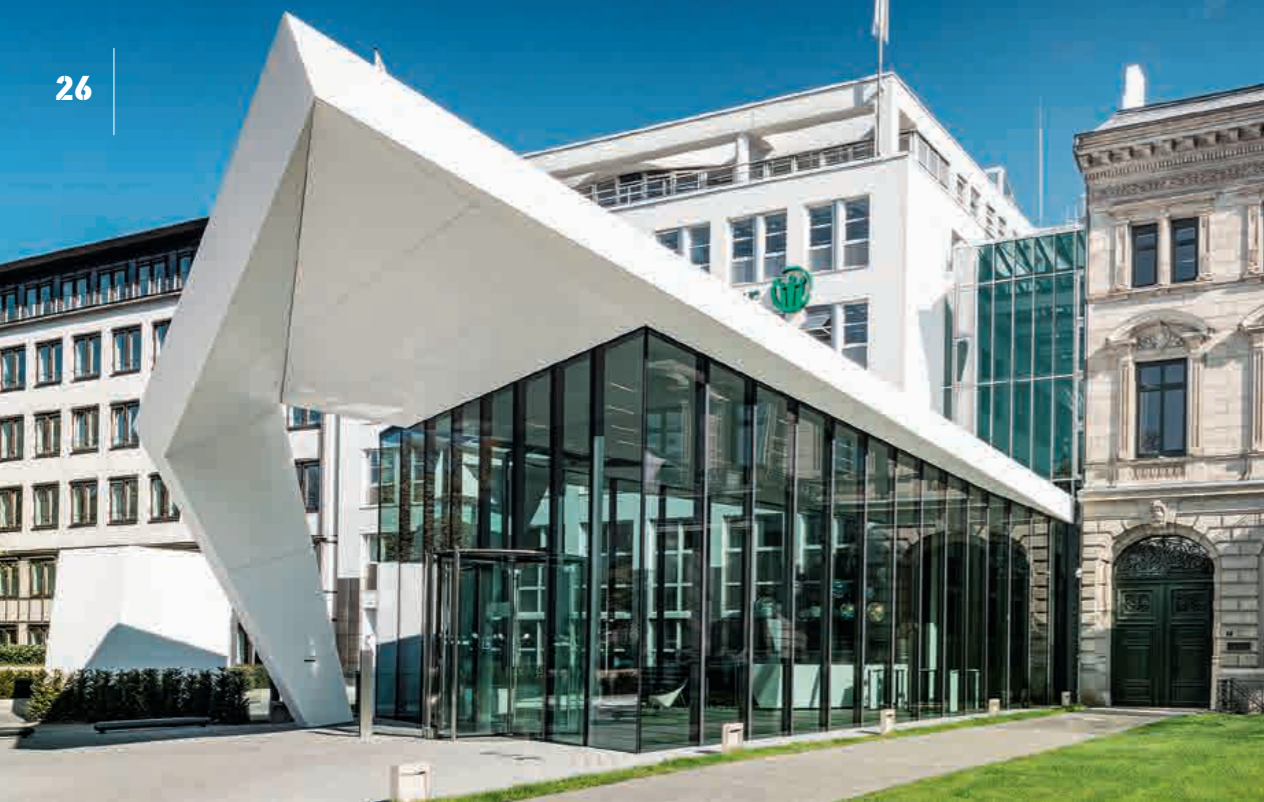
Modern gestaltet, handwerklich meisterhaft ausgeführt: das neue Empfangsgebäude der Hanse-Merkur Versicherung in Hamburg.
