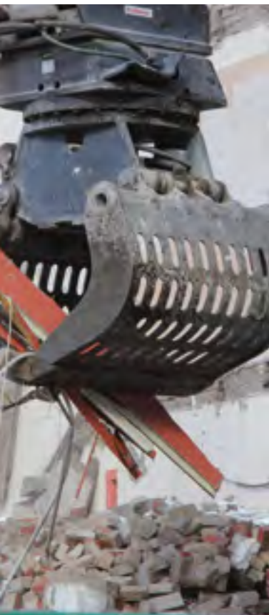
▲ Der Abriss des Altbestands Bramfelder Straße ist erfolgt.
