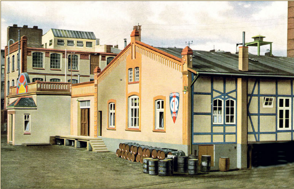
Zeichnung an der Außenfassade eines Produktionsgebäudes.
