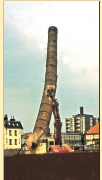
Der Schornstein wurde nicht gesprengt, sondern von einem Bagger umgelegt.
