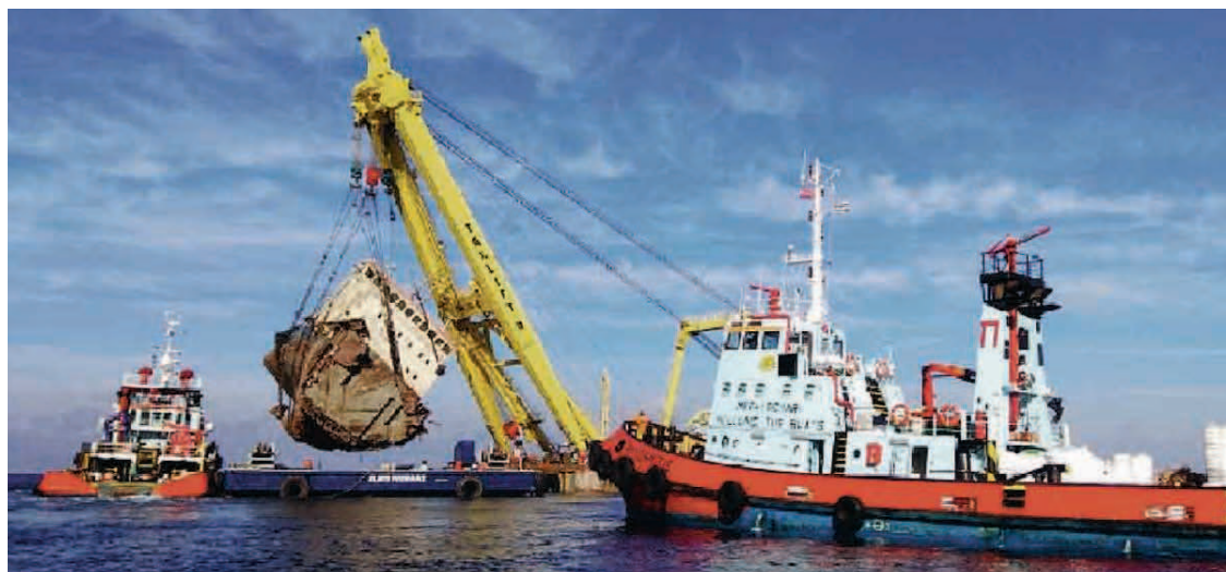
Schwimmkran „Taklift 4“ aus Holland hatte das Achterschiff der zerbrochenen „Cabrerera“ auf einen Ponton gehoben
