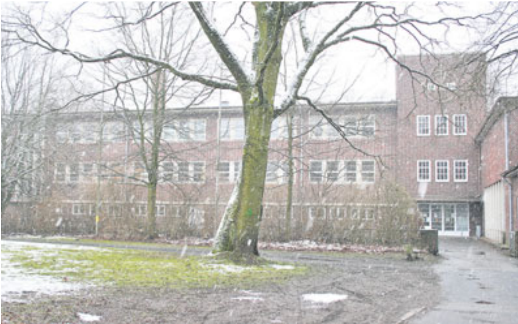
Das Schulgebäude in Berne gliedert sich in zwei über Ecke stehende Baukörper: Klassentrakt und Turnhalle, die durch ein Treppenhaus verbunden sind
