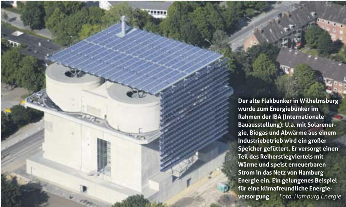
Der alte Flakbunker in Wilhelmsburg wurde zum Energiebunker im Rahmen der IBA (Internationale Bauausstellung): U.a. mit Solarenergie, Biogas und Abwärme aus einem Industriebetrieb wird ein großer Speicher gefüttert. Er versorgt einen Teil des Reiherstiegviertels mit Wärme und speist erneuerbaren Strom in das Netz von Hamburg Energie ein. Ein gelungenes Beispiel für eine klimafreundliche Energieversorgung Foto: Hamburg Energie
