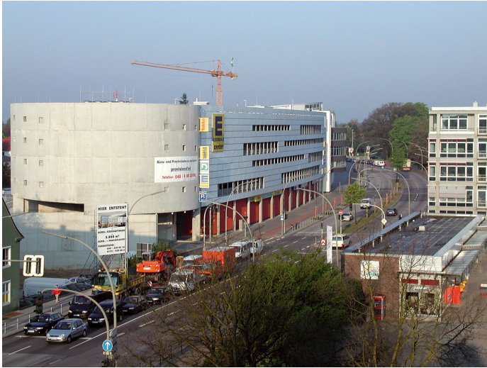
Das Krohnstieg Center im Bau.
