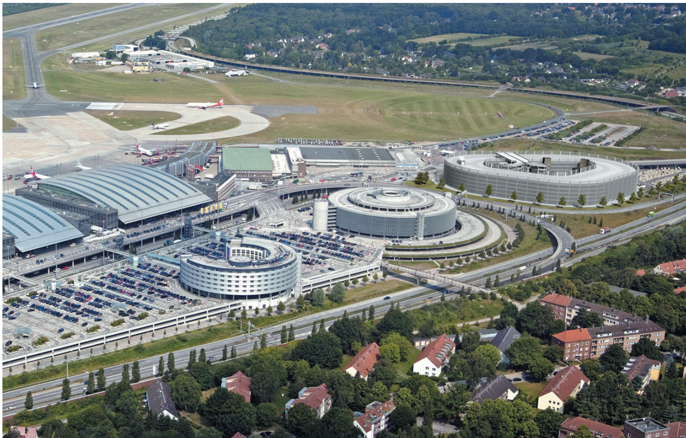
Das neue Parkhaus (rechts im Bild) aus der Vogelperspektive. Fotocollage im Auftrag der Flughafen Hamburg GmbH durch Gärtner + Christ GbR. Foto Michael Penner
