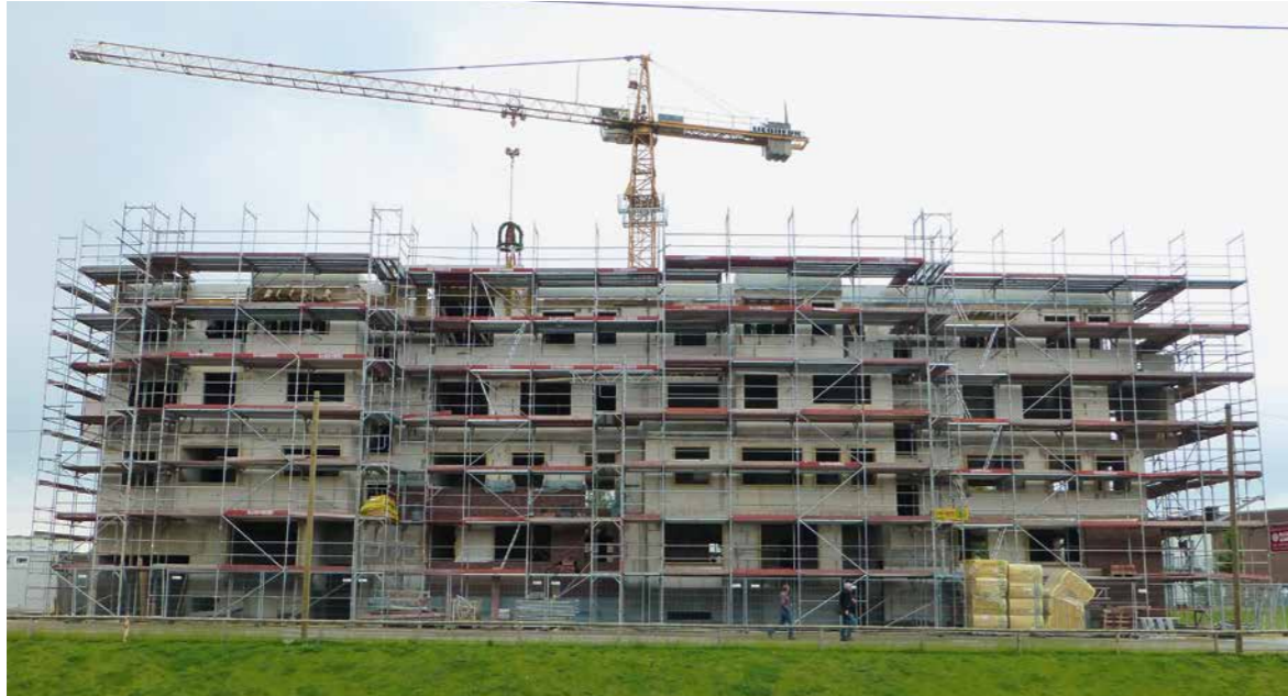
Bauprojekt einer Baugemeinschaft in der Jenfelder Au
