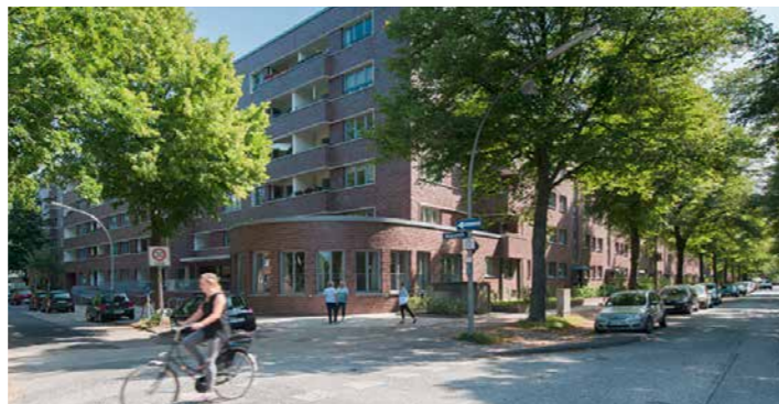
Rungehaus als Mittelpunkt für das Projekt LeNa in Barmbek-Nord
