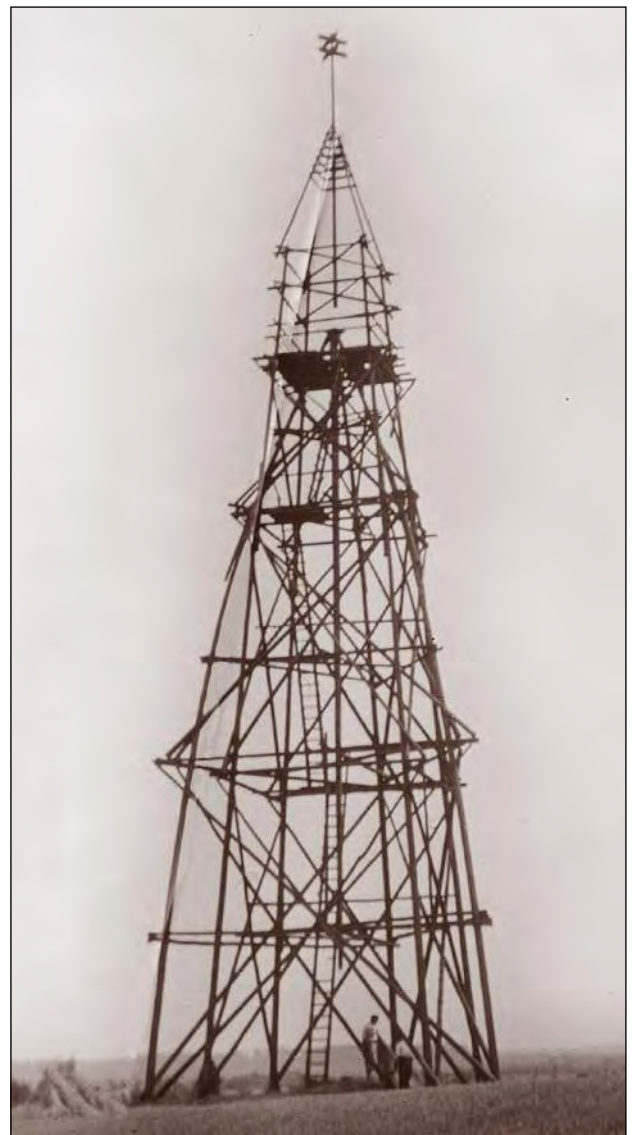
Beispiel eines Vermessungsturmes: Die getrennt stehenden Holzgerüste der Beobachtungs- und Signalpyramide über dem TP Havighorst; Foto um 1920
