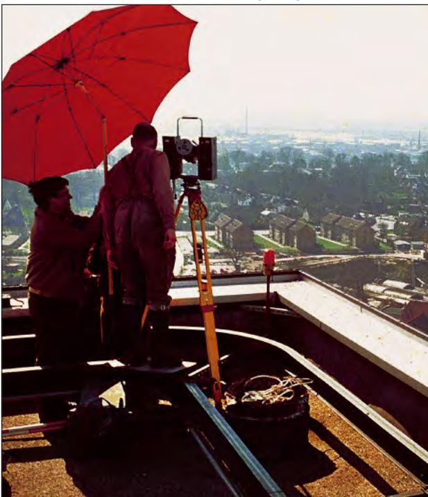
Mit der später fortschreitend technischen Entwicklung begann um 1970 der Einsatz der elektro-optischen Entfernungsmessung; so bei Großbauwerken: u.a für die „A 7 - Westliche Umgehung“ mit dem neuen Elbtunnel (Freigabe 10.1.1975), die Köhlbrand-Hochbrücke und bei weiteren Arbeiten im Netz III. und IV. Ordnung. Ergänzt wurde diese Entwicklung durch den Einsatz rechnergestützter Ausgleichsverfahren.
