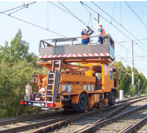
Ein Turmwagen mit isolierter Arbeitsplattform wird für Arbeiten an der Fahrleitung eingesetzt.
