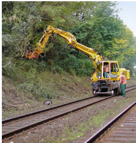
Ein Zweiwegebagger eignet sich auch für die Grünpflege am Gleis.
