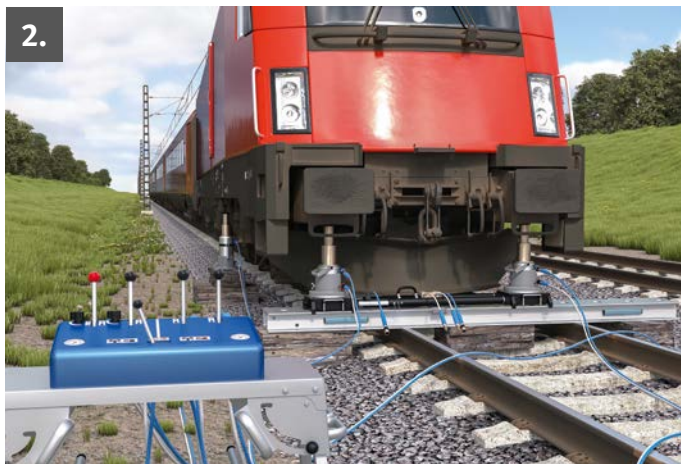
Zwei Zylinder auf der Aufgleisbrücke übernehmen die Last.
