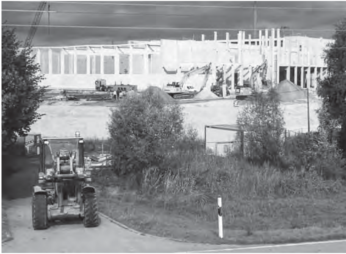
Blick vom Oberg Georgswerder Hauptdeich auf die Baustelle. Bereits jetzt sind die Gebäude für Transgourmet so hoch, dass man Kühne + Nagel dahinter nicht mehr sieht. Foto: sic
