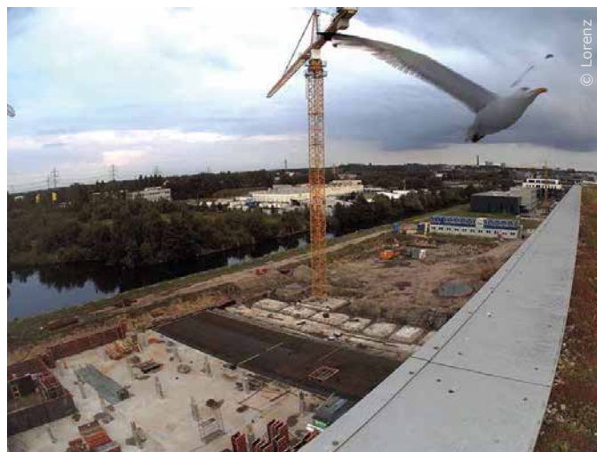
Blick von oben: Die Webcam liefert aktuelle Bilder der Baustelle.
