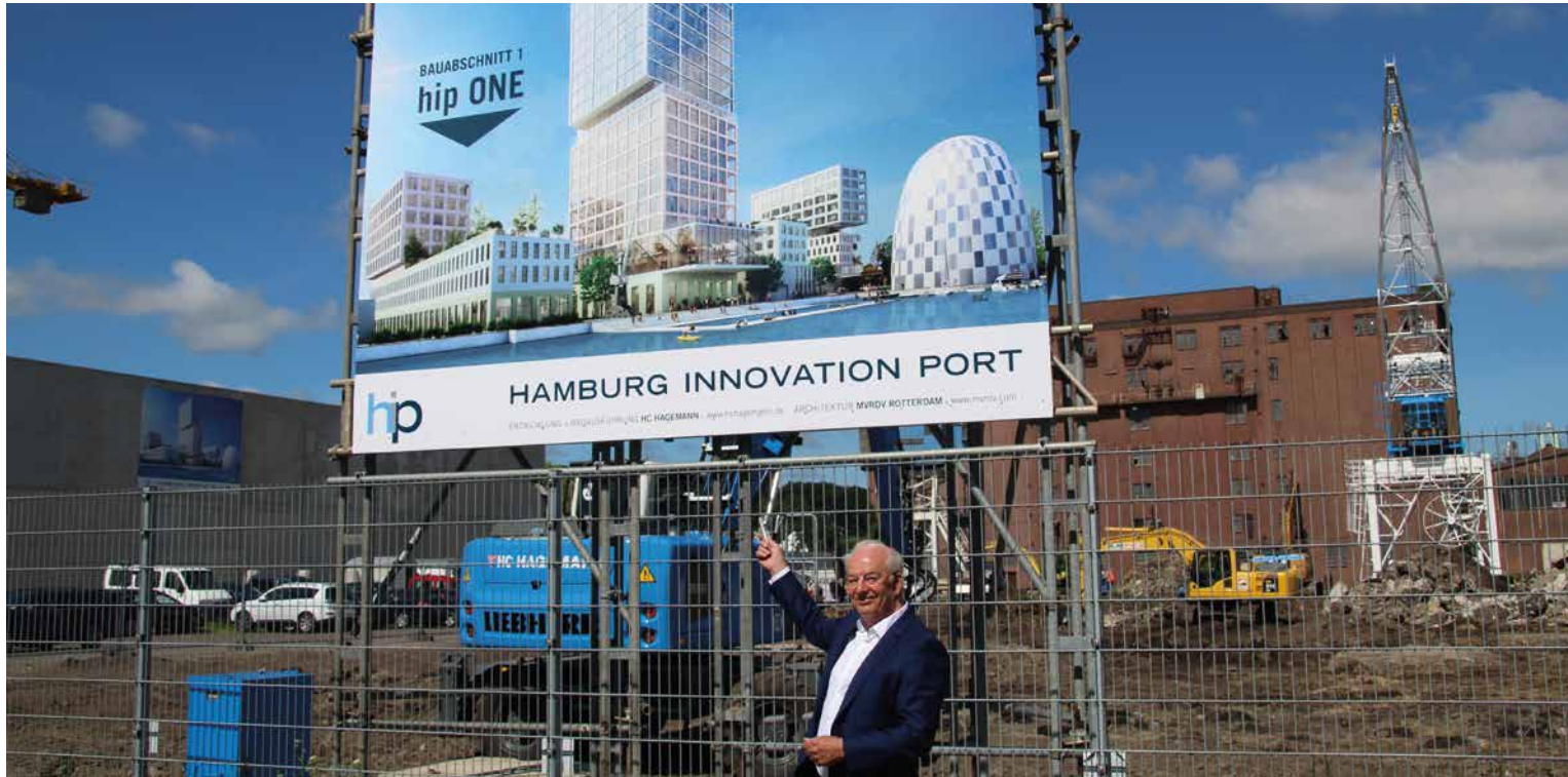
Das nächste große Ding: Arne Weber vor dem Baugelände für den Hamburg Innovation Port.
