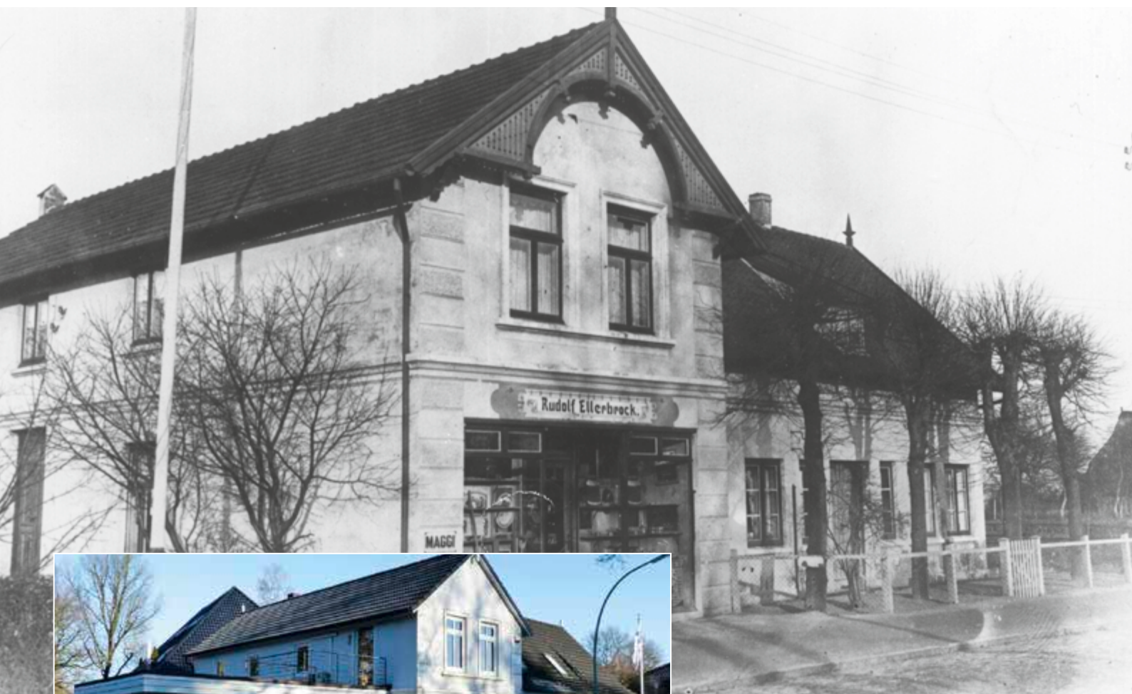
Duvenstedter Damm 24-26 damals (30er)
