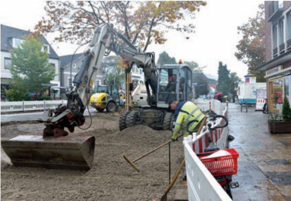
Die Bauarbeiten des ersten Bauabschnitts gehen weiter
