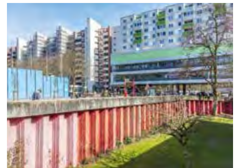
Die Gründgenstraße, eingefasst von Spundwänden. – Ein Indiz für einen unterirdischen U-Bahnhof?
