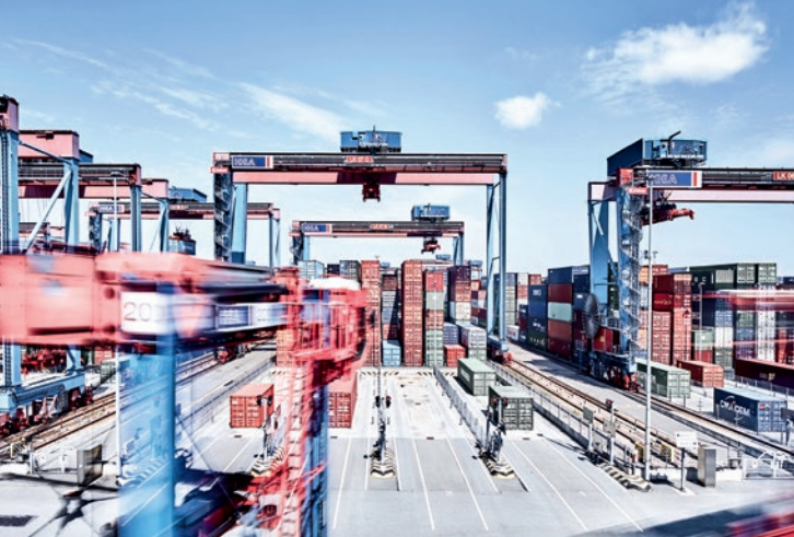
Terminal Burchardkai: automatische Lagerblöcke für Container.
