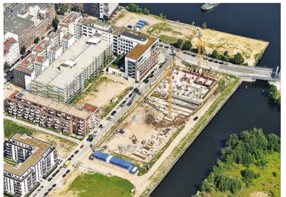
Blick auf einer Großbaustelle im Harburger Binnenhafen: In der Bildmitte wächst das Brückenquartier (Bericht siehe oben), auf der freien Fläche darüber sollen das neue Hotel und die L'Osteria gebaut werden. Die Kaimauerabsenkung ist für den freien Platz zwischen der L'Osteria und dem Kaispeicher (oben links) geplant. Foto: Lorenz Gruppe
