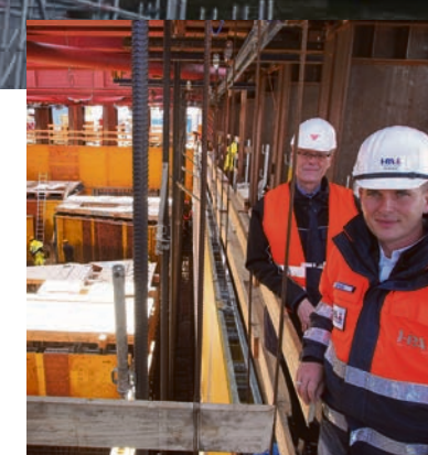
HPA-Projektleiter Sebastian Schulz (rechts) und HCH-Prokurist Thorsten Saefkow auf der Baustelle.
