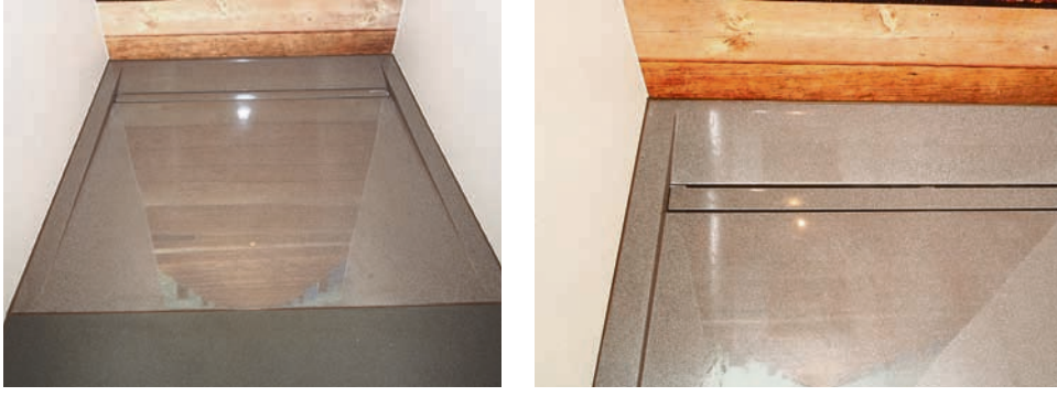
So kann eine „Duschwanne“ auch aussehen: bodengleich mit eingearbeiteter Ablaufrinne.
