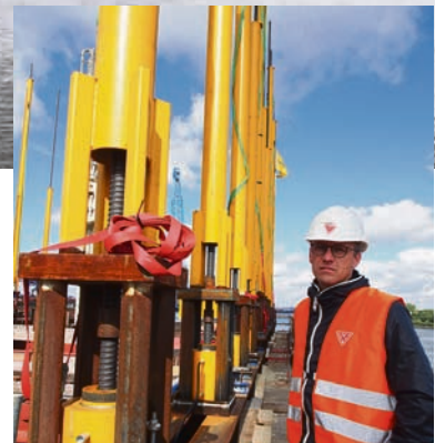
HCH-Bauleiter Heiko Harring zeigt die Reihe der Gewindestangen, an denen die tonnenschwere Last hängt. Die Hydraulikpressen werden synchron gesteuert, damit sich das Bauwerk gleichmäßig senkt.
