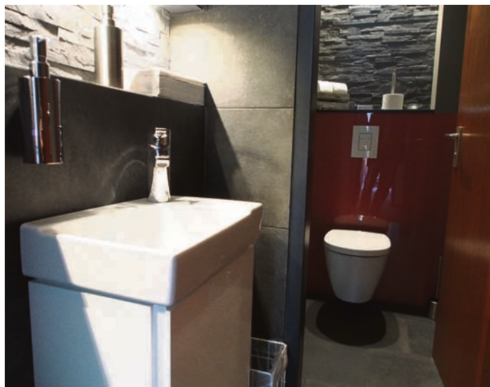
Naturstein, ruhige Farben, hochwertige Komponenten – eine Gästetoilette à la Hartmann Haustechnik.
