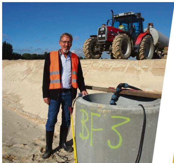
HI-Mitarbeiter Ulrich Roder leitet das Gesamtprojekt. Hier steht der Bauingenieur an einem der Schächte, über die das aus dem Torf herausgedrückte Wasser abgepumpt wird.
