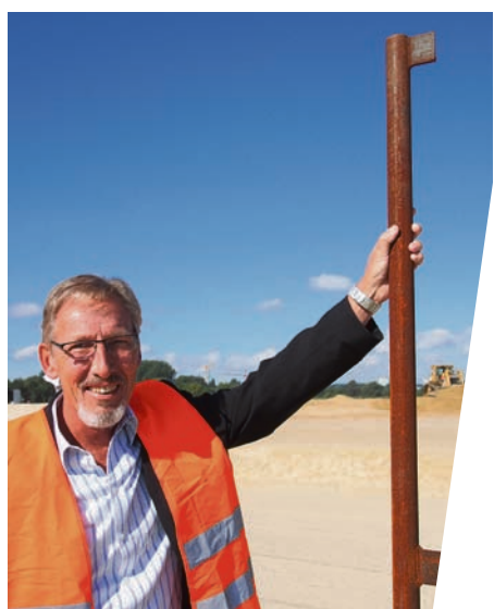
Diese Messpegel sind überall auf der Fläche verteilt. Sie senken sich mit der Sandplatte langsam ab und geben Aufschluss über den Setzungsverlauf.
