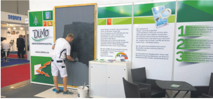
Mit Spachtelmasse gegen störende Strahlung: Ein Mitarbeiter der Firma HEKA graphit technology demonstriert das Auftragen der Absorberschicht.
