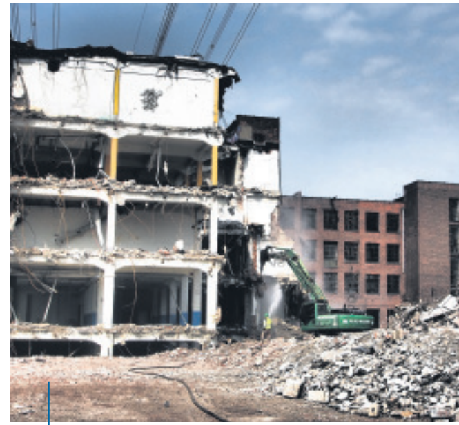
Bagger marsch: So sah es vor wenigen Wochen an der Seehafenstraße in Harburg aus. Hier wird eine Fläche für die Ansiedlung einer Spedition und der Firma Mateco vorbereitet. Foto: Wolfgang Becker
