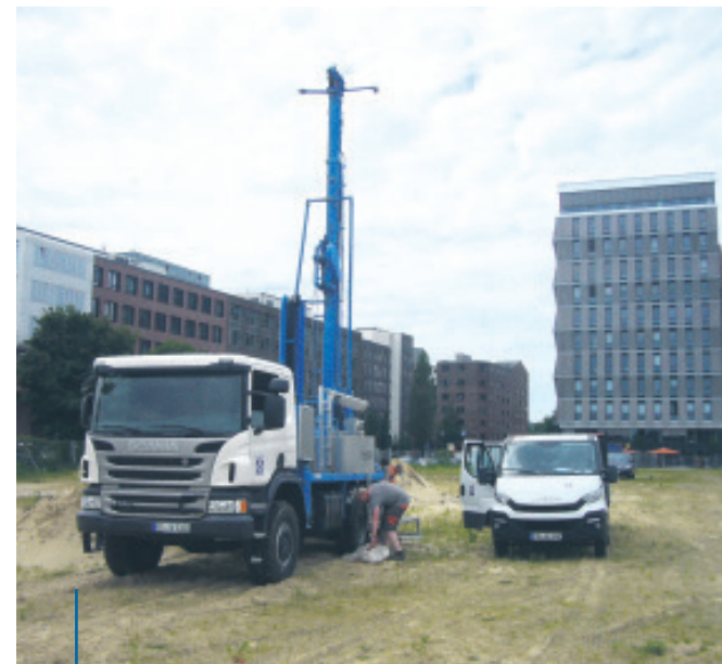
Auf der ehemaligen Beachclub-Fläche am Veritaskai ist ein Bohrergerät zur Untergrundanalyse in Stellung gebracht worden. Hier soll das Hotel gebaut werden.
