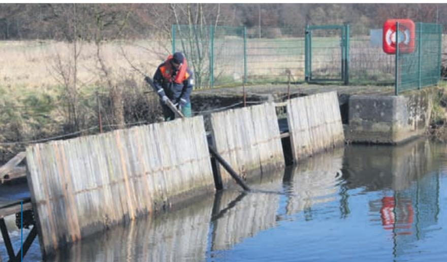
Ausgefeilte Technik: Der Durchfluss der Wassermenge durch das Nadelwehr wird durch die Anzahl der „Nadeln“ bestimmt, die entfernt oder hinzugefügt werden. Foto: Landkreis Lüneburg
