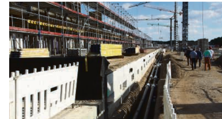
Der IlmenauGarten wird an ein Fernwärmenetz angeschlossen. Ganz rechts: Der Eisenflechter im Einsatz.
