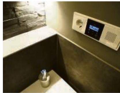
Auf Gehrung eingepasst: So sieht eine Fliesenkante à la Hartmann Haustechnik aus. Rechts: ein in die Wand eingebautes Radio – damit es beim Duschen nicht langweilig wird ...
