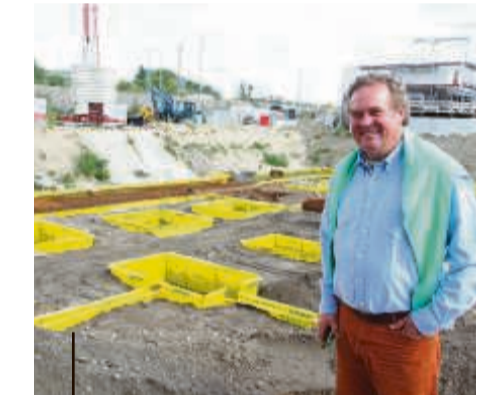
Wido G. Aniszewski vor der Baugrube am Wasserplatz: Hier entsteht das „Haus am Ilmenauwehr“ von der Harburger Vermögensverwaltungsgesellschaft Wilhelm Wertheim Nachfahre.
