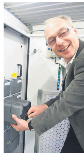
Elektromeister Peter Henning zieht an einem Stromspeicher eines von mehreren Strom-Speichermodulen heraus.
