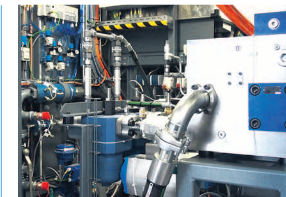
Ein Fall für Spezialisten: Oliver Horn vor dem mehr als zwei Meter hohen Schaltschrank des Danfoss-Hydraulik-Prüfstands. Seine Aufgabe sind der Einbau und die Verkabelung der Bauelemente. Auch die Lüfter und die Kühlanlagen gehören zur elektrotechnischen Ausstattung. Fotos: Wolfgang Becker
